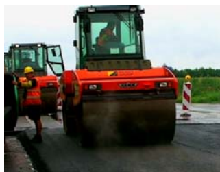
Zhutňování asf. směsí válcováním
