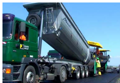
Doplňování zásobníku finišeru z nákladního automobilu
